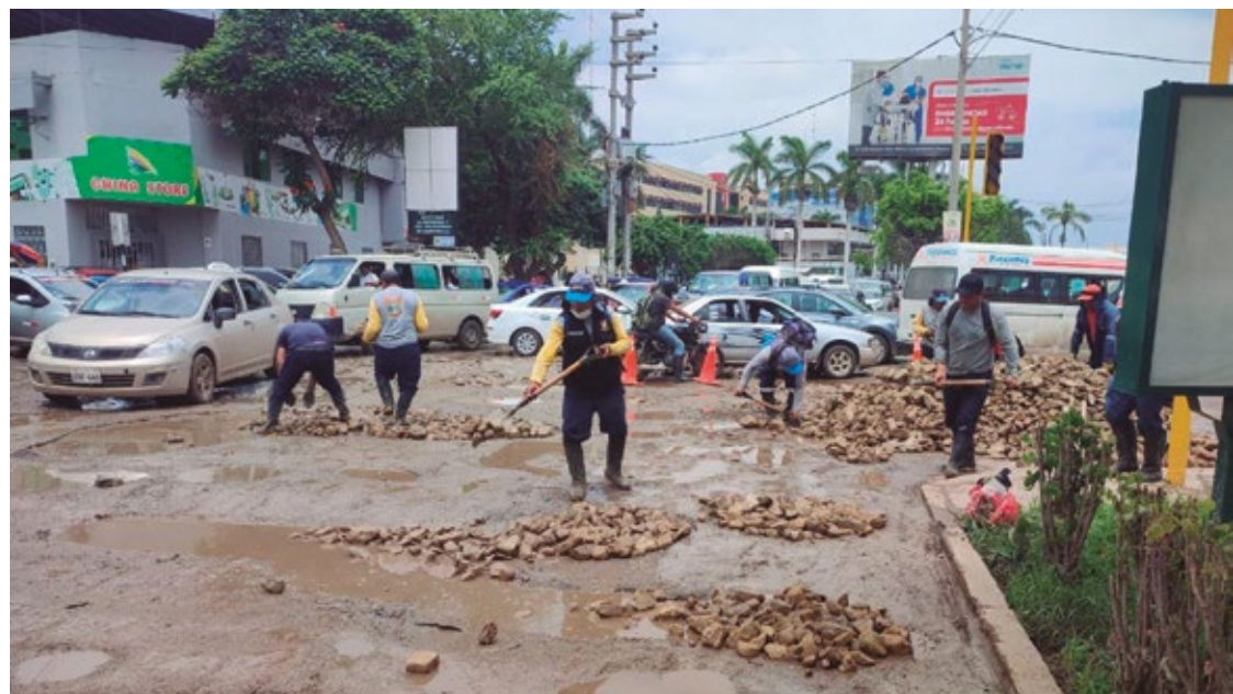
Municipalidad provincial de Chiclayo, a través de la Subgerencia de Obras, ejecuta acciones provisionales de emergencia.
